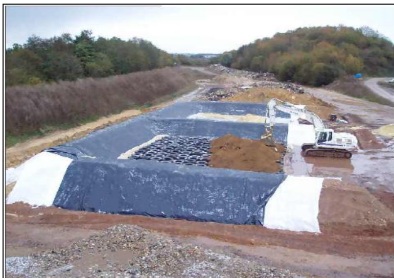
Figure 6 : Alvéoles en cours de remplissage
